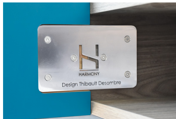
Plaque métallique de liaison entre voile de fond et retour (côté intérieur), signée par le designer Thibault Desombre
